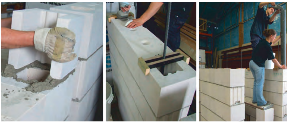
› HERSTELLUNG BEWEHRTES KALKSAND-STEIN-MAUERWERK
