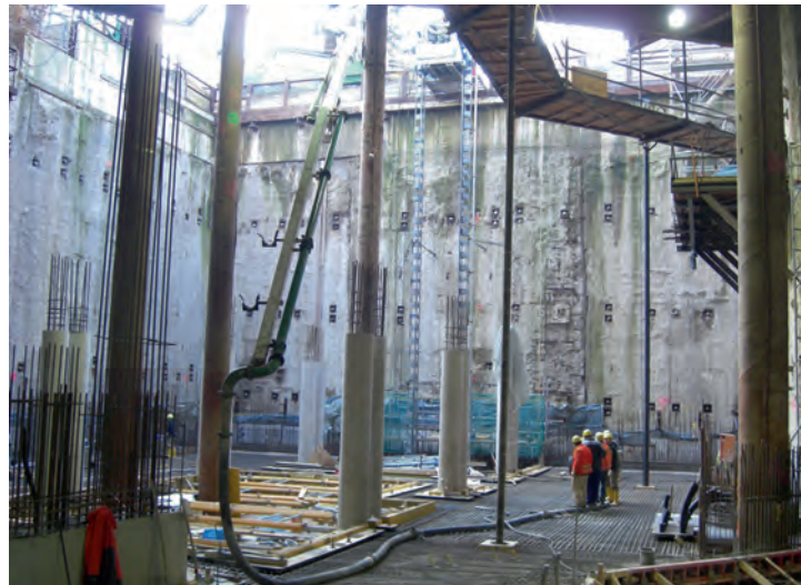
› BAUSTELLE U-BAHNHOF HEU-MARKT IN KÖLN
